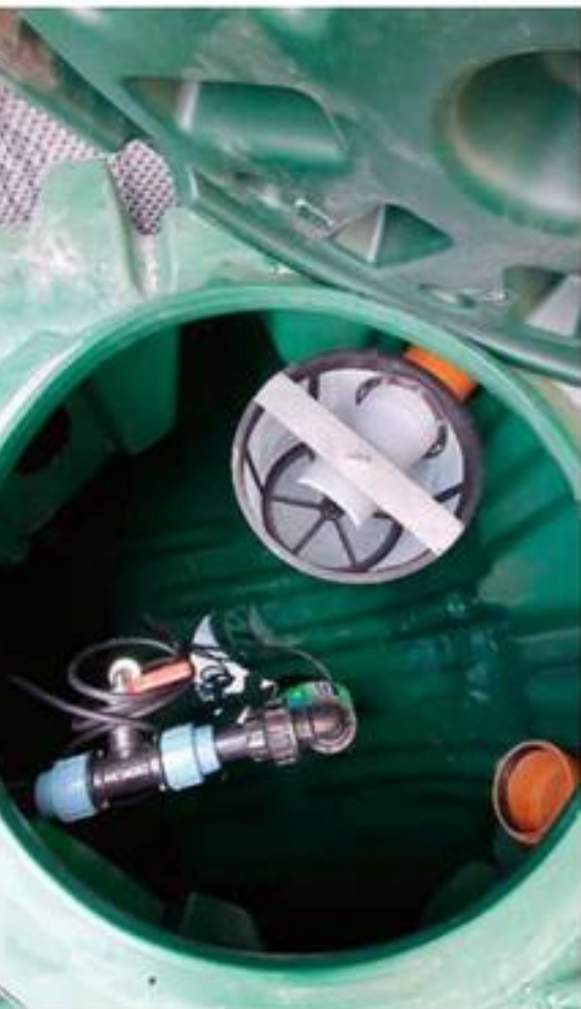
Pohled do akumulační nádrže po vyčištění dešťové vody od biologických nečistot
