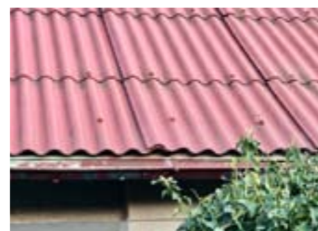
Moderní vláknocementová vlnitá krytina bez azbestu neuvolňuje závadné částice a je použitelná pro odvod dešťové vody
