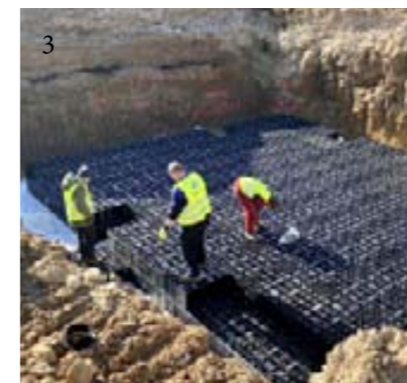
Postup instalace vsakovacích bloků: 1. Vyhlobená jáma s pažením a zhuťným šterkovým podkladem, 2. a 3. Opatrná montáž vsakovacích bloků na položenou geotextilii 4. Sazení ústíčních trubek a obalení geotextilií. Následuje opatrné zahrnutí zeminou
