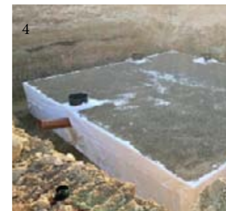
Postup instalace vsakovacích bloků: 1. Vyhlobená jáma s pažením a zhuťným šterkovým podkladem, 2. a 3. Opatrná montáž vsakovacích bloků na položenou geotextilii 4. Sazení ústíčních trubek a obalení geotextilií. Následuje opatrné zahrnutí zeminou
