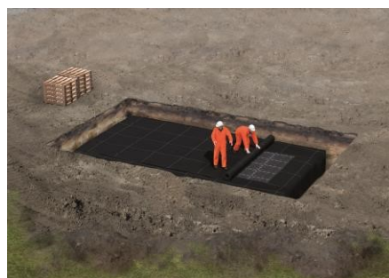
Obrázek 13: Zakrytí geotextilií
