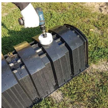
10. Vyvrtejte díru do těla tunelu
